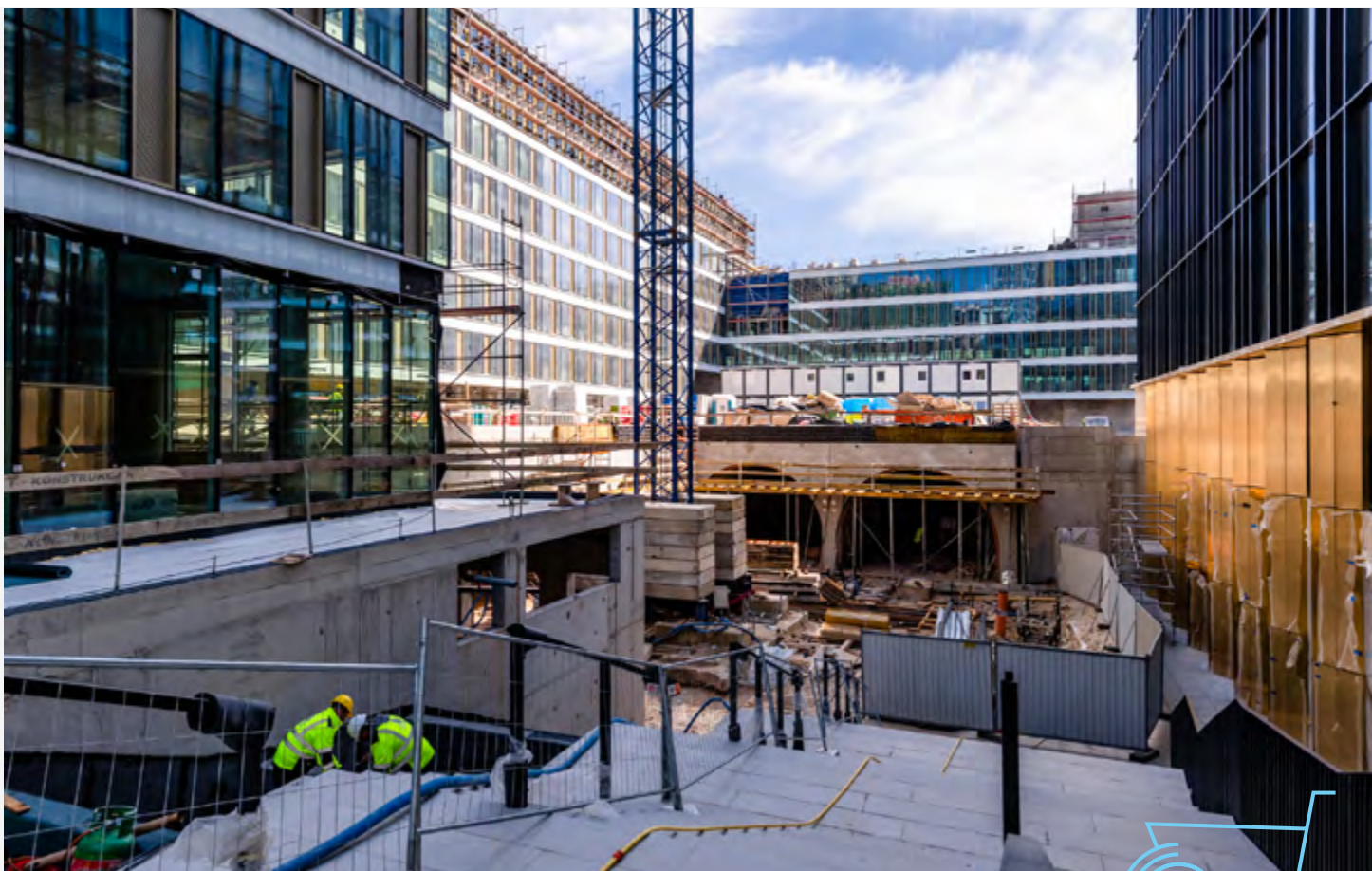
Prace wykończeniowe budynku Biura przy Warzelnii w kompleksie Browary Warszawskie
